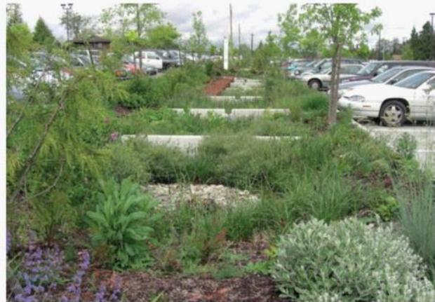
Imagen 19. Biorretención en camellón de estacionamiento.
