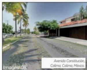
**Empedrado permeable con huellas de rodamiento vehicular**
