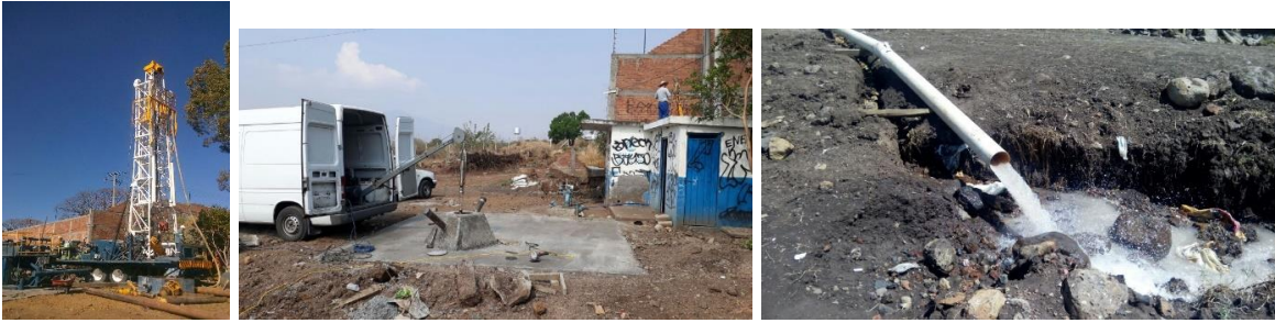
PERFORACIÓN DE POZO PROFUNDO EN LA COLONIA GUADALUPE VICTORIA (TANGANXOAN)
