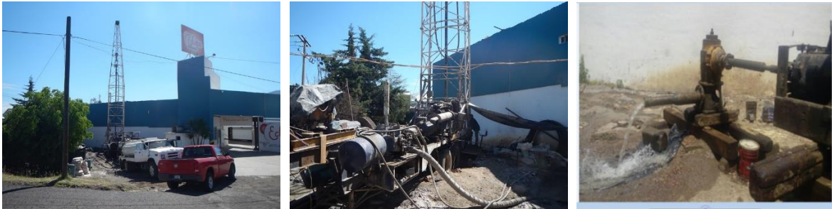
PERFORACIÓN DE POZO PROFUNDO EN LA COLONIA ETNIAS DE MÉXICO
