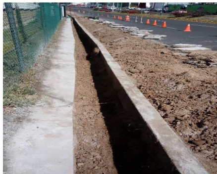
SUSTITUCIÓN DE LÍNEA DE CONDUCCION Y REEQUIPAMIENTO DEL REBOMBEO BRITANIA II A COLONIA VALLE DE LAS FLORES, CON TUBERIA DE PVC RD 26 Y DE ACERO CEDULA 40, DE 6" DE DIAMETRO, PARA INCREMENTAR LA PRESION EN LA DISTRIBUCIÓN Y MEJORAR EL SERVICIO EN LA ZONA
