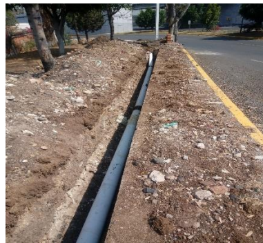
SUSTITUCIÓN DE LÍNEA DE CONDUCCION Y REEQUIPAMIENTO DEL REBOMBEO BRITANIA II A COLONIA VALLE DE LAS FLORES, CON TUBERIA DE PVC RD 26 Y DE ACERO CEDULA 40, DE 6" DE DIAMETRO, PARA INCREMENTAR LA PRESION EN LA DISTRIBUCIÓN Y MEJORAR EL SERVICIO EN LA ZONA
