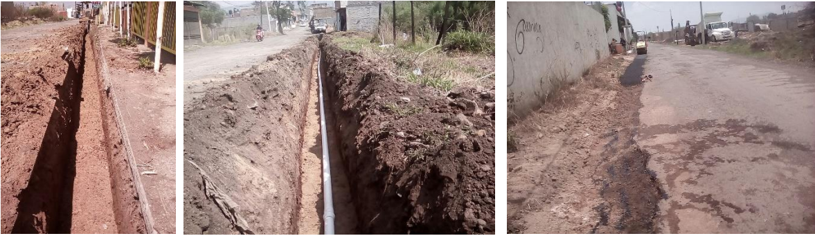
CONSTRUCCIÓN DE RED DE DISTRIBUCIÓN EN LA COLONIA HÉROES INSURGENTES, CON TUBERIA DE PVC RD 26 EN DIFERENTES DIAMETROS, PARA AMPLIAR LA COBERTURA DEL SERVICIO EN LA COLONIA
