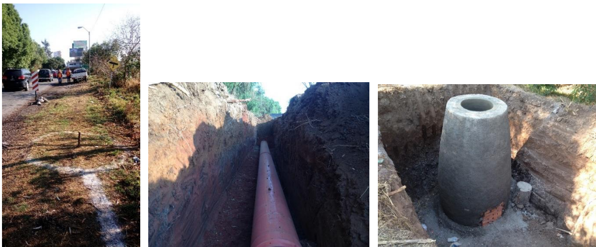
CONSTRUCCION DE COLECTOR SANITARIO ZIMPANIO, SEGUNDA ETAPA
