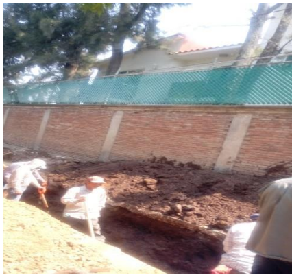
SUSTITUCIÓN DE RED SANITARIA CALLE CAMELINA, ENTRE CAMELINA BLANCA Y ARROYO BLANCO, INCREMENTO DE DIAMETRO A 18" EN PVC SANITARIA SERIE 25, PARA MEJORAR LA CAPACIDAD DE CONDUCCIÓN
