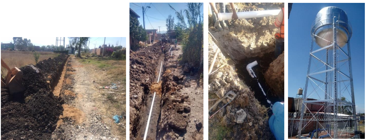
CONSTRUCCIÓN DE LA RED DE AGUA POTABLE PARA LAS COLONIAS AMPLIACIÓN LAGO I, GERTRUDIS SÁNCHEZ, VALLE DE LOS MANANTIALES SEGUNDA ETAPA, WENCESLAO VICTORIA, DE LA ZONA NORTE DE MORELIA (PRIMERA ETAPA)
